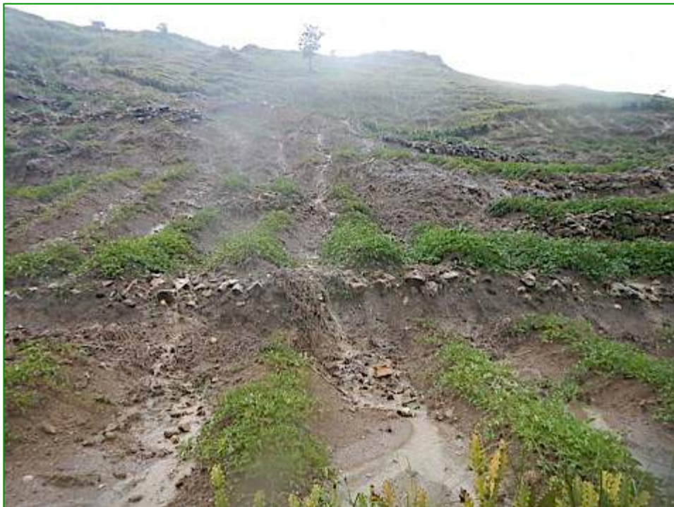
Chemins d'érosion de l'eau lors d'une pluie journalière au mois de septembre.
