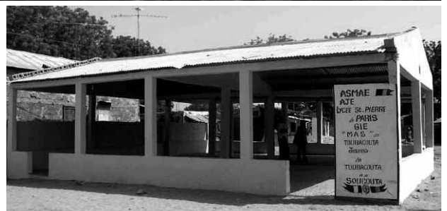
Le marché couvert de Toubacouta terminé en mai
