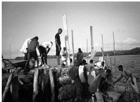
Rénovation du ponton
