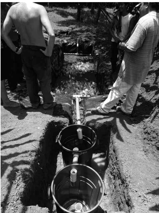
Discussions de chantier autour du biofiltre partiellement rempli de bouteilles en PET. Premier plan : traitement primaire. Second plan : traitement biologique. Photo: J. Canton
