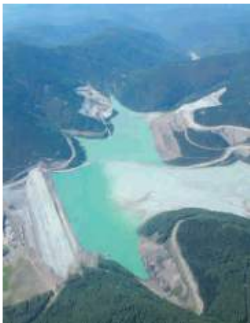
Fotografía 2: Dique de colas.
