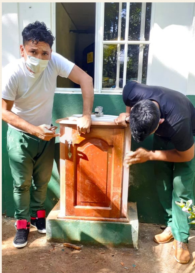
Illustration 2 : Mise en place d'un évier à l'entrée du Centre Agroforestier de Wawashang. Même en situation d'urgence, l'esthétique reste primordiale pour ces étudiants en ébénisterie.
