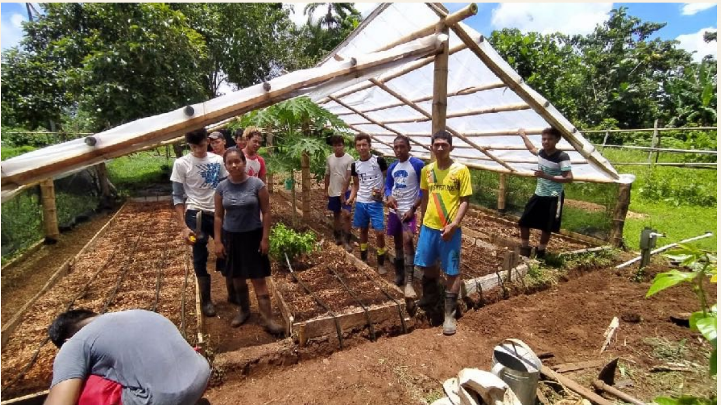
Illustration 8 : Montage de la structure en bambou, pose du plastique, rénovation des lits en permaculture et pose du système d'irrigation
