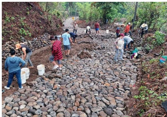
Restauration de la rue d'entrée du village
