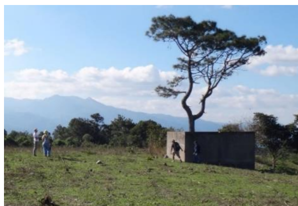
Ancien réservoir d'eau
