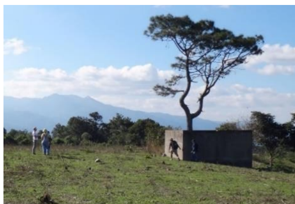
Ancien réservoir d'eau
